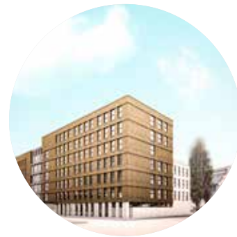
Bouw van een nieuw woonzorgcentrum Vishay
